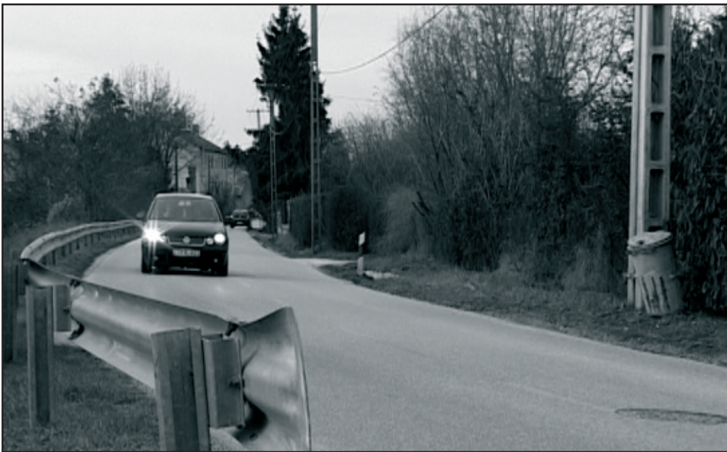
A járda megépítésével megszűnik az életveszélyes közlekedés az Arácsi út egy részén
