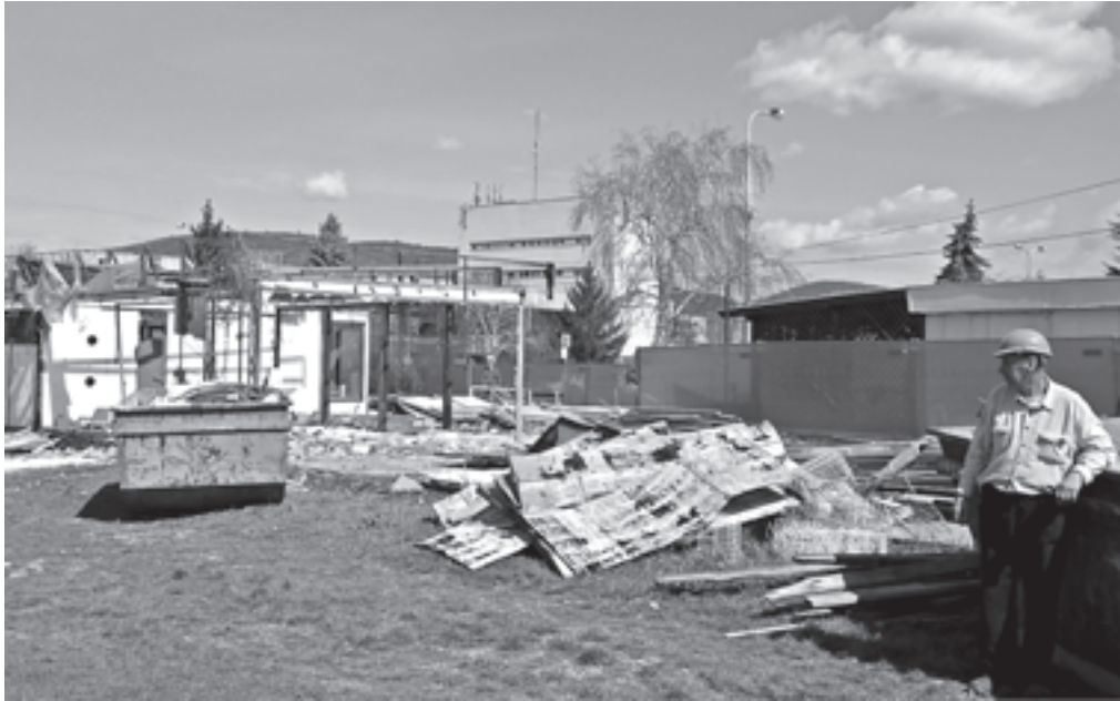
Az egykori vendéglátóhelyek bontásával megkezdődött a busz-, illetve a vasútállomás rehabilitációja
